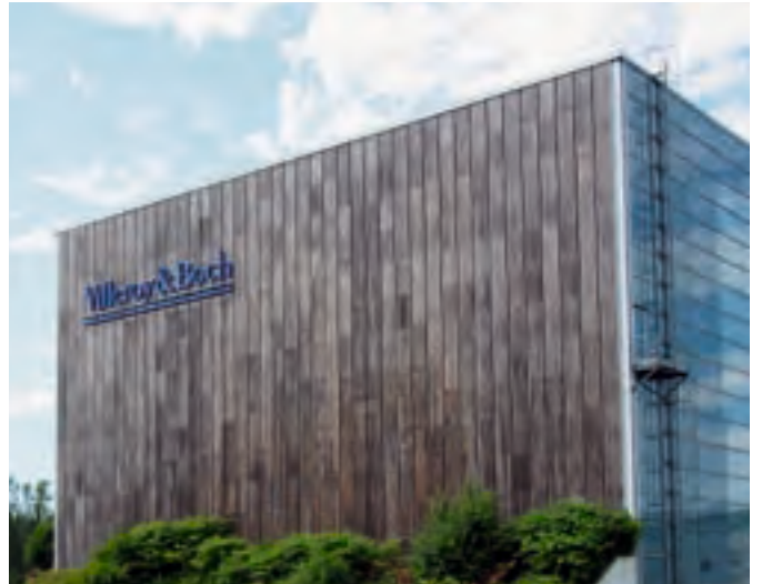
GEWERBEBAU VILLEROY & BOCH, KERTO-FASSADE, KESSELDRECKIMPRÄGNIERT
